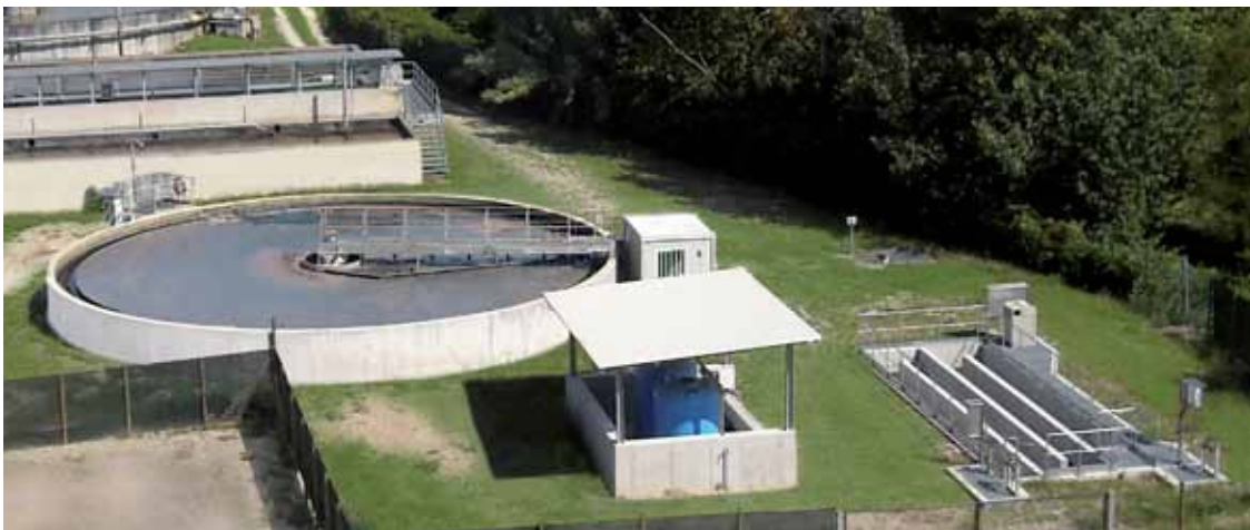
Uno scorcio dell'impianto di depurazione di San Vito al Tagliamento, recentemente rinnovato ed implementato
