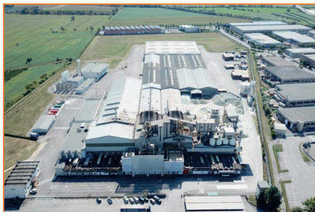
Vista aerea dello stabilimento
